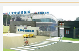
北京中能建医院 一甲综合
