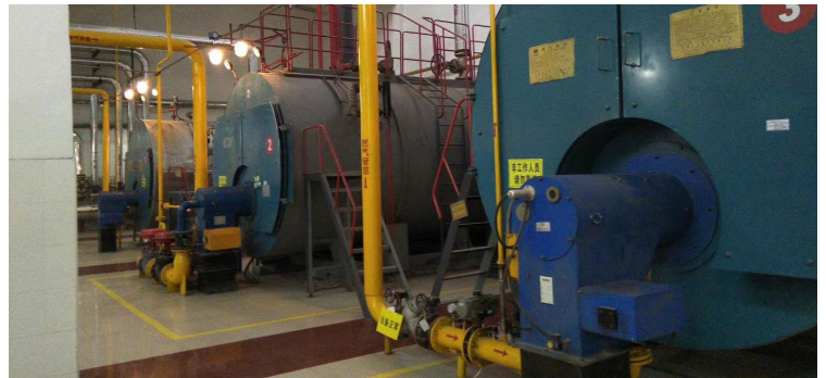
锅炉低氮改造
